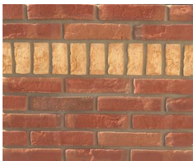
(basismetselwerk bij bnr090)
